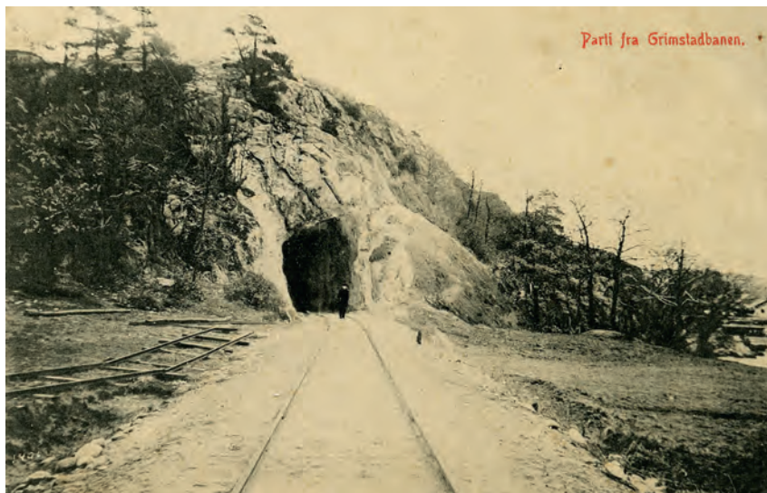
«Parti fra Grimstadbanen». Vi ser situasjonen i Saulebukta. Det måtte mineres en tunell for å føre jernbanelinjen frem til stasjonsområdet ved Vestrebukt. Banen het i det daglige Grimstadbanen helt fra starten 1907. Postkort: Utgitt av Cigarforretningen Trio, Grimstad, postgått, og datert 31. januar 1908.
