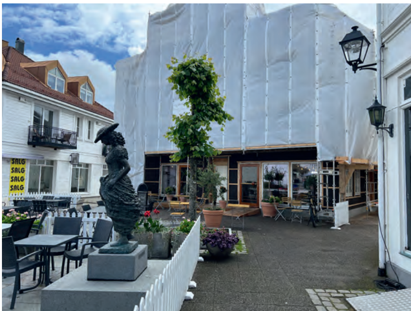
Central Hotell i 2024, utvendig reparasjon pågår sommeren 2024. Foto: Helge Grobæk.
