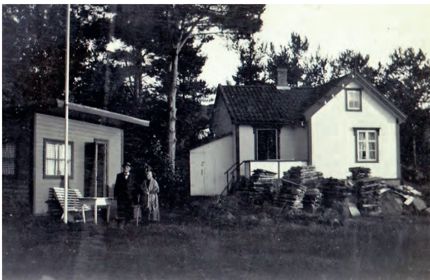
Jens Bertinius og Marie ved bua som ble flyttet fra fergestasjonen på Rønnes og huset han bygde ved Hesneskanalen i 1932.
