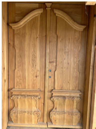
Ny dobbeltbladet eikedør, og nøyaktig kopi av den gamle fra tidlig 1700-tallet. Foto Helge Grobæk.
