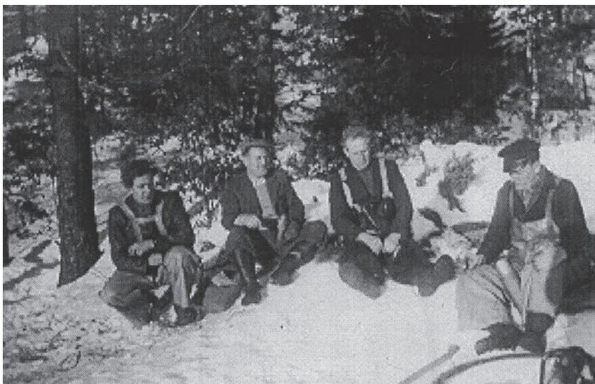
Etter tunge snøfall med linjebrudd, var det nødvendig «å gå linjen» for å finne og bruddet. Ser idyllisk ut, men virkeligheten kunne være ganske tøff. Fra venstre: Overmontør Gunnar D. Guttormsen, Torleif Pedersen, ukjent og Johannes Pedersen. Foto: Utlånt av Finn Fredvig Erichsen
