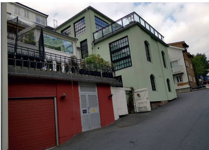
Dagens ombygde trafo. Foto: Helge Grobæk.
