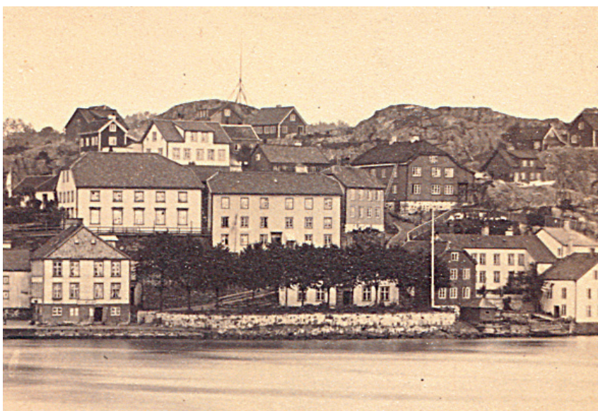
Nedre batteri i Arendal. Det var slettes ikke noe slikt batteri som befant seg på Boddén. (Arendalsbilder, Kuben)
