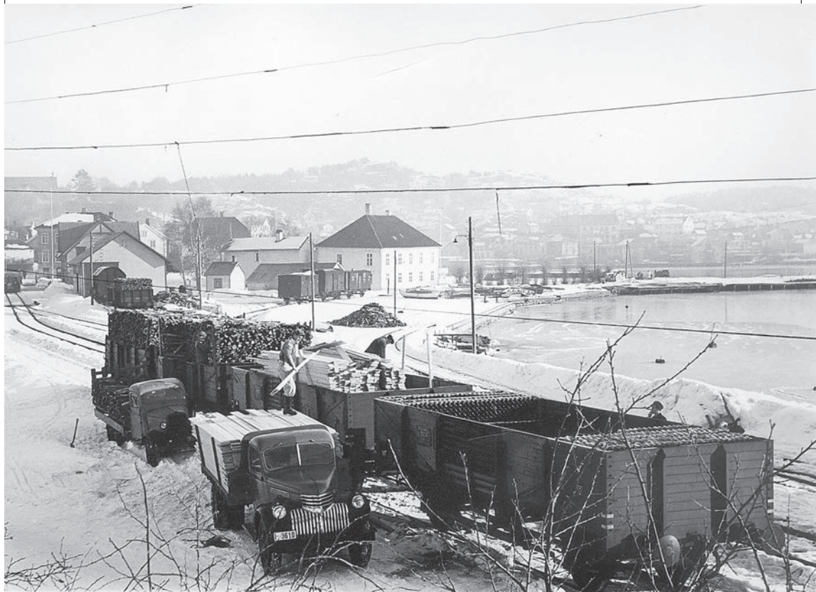
Endelig, i 1907, etter mange års strev og korridorpolitikk for å sikre jernbane til Grimstad, kunne en løse billett til Rise. Dette bildet er fra 1950-åra, mens det stadig var mye godstrafikk over Grimstad Jernbanestasjon. Grimstadbanen ble til slutt lagt ned i 1961. Foto utlånt av Roald Hanssen.
