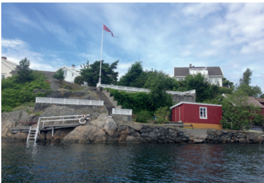
Noe av Bioddpynten sett fra sjøen i vår dager. Båtbyggeriets øvre venstre hjørne var der flaggstangen står, og dets nedre høyre hjørne var enden av den røde båtboa. Dennes langsida med vindu var en del av båtbyggeriets underetasje, og andre deler av grunnmur/underetasje finnes fremdeles hele veien rundt. Foto: Gunnar B. Mathisen
