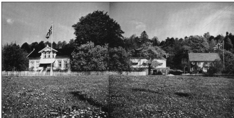
Gården Ugland. Til høyre det eldste huset fra 1831. I midten den første kontorbygningen fra 1948. Til venstre sveitserhuset hvor de bodde lengst. Oppført av byggmester Heinecke i 1870-årene.
